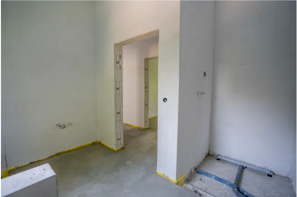
Badezimmer Whg. 2 OG
