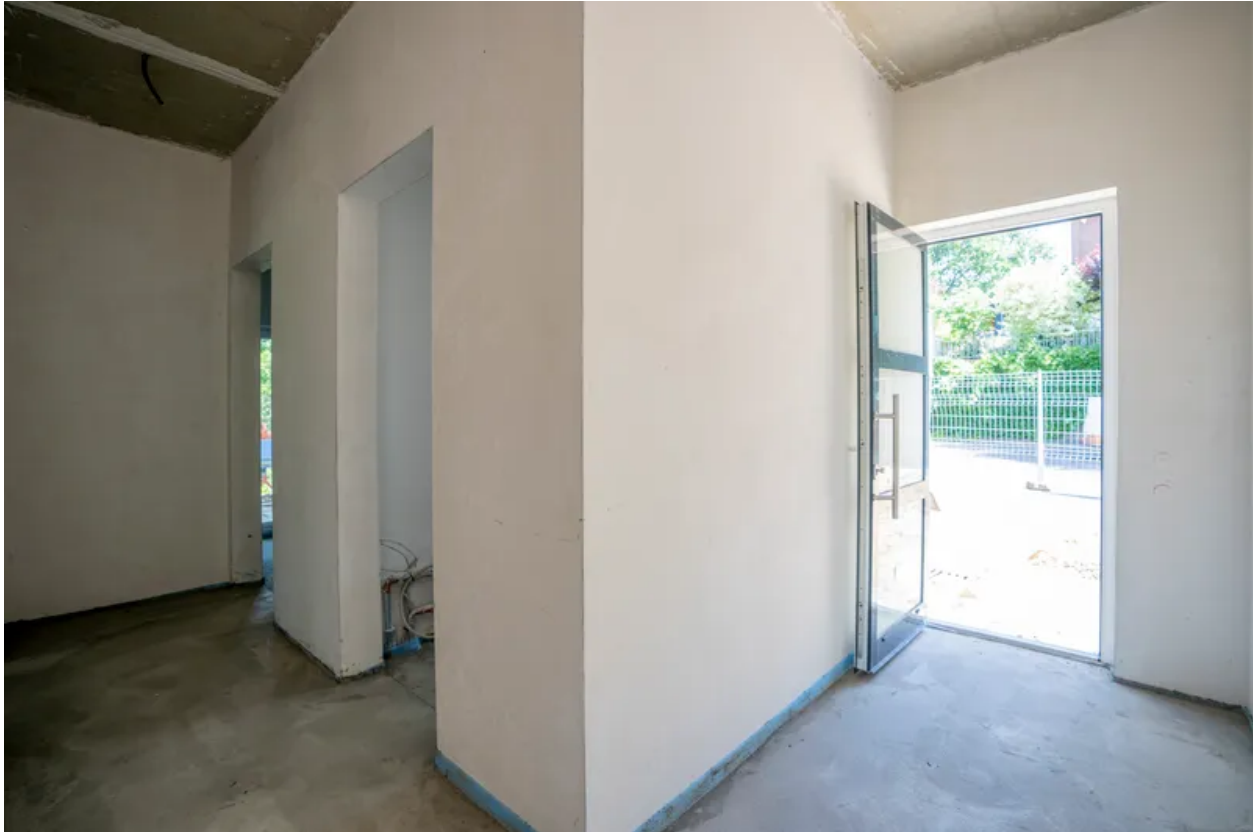
Eingangsbereich Whg. 1 EG
