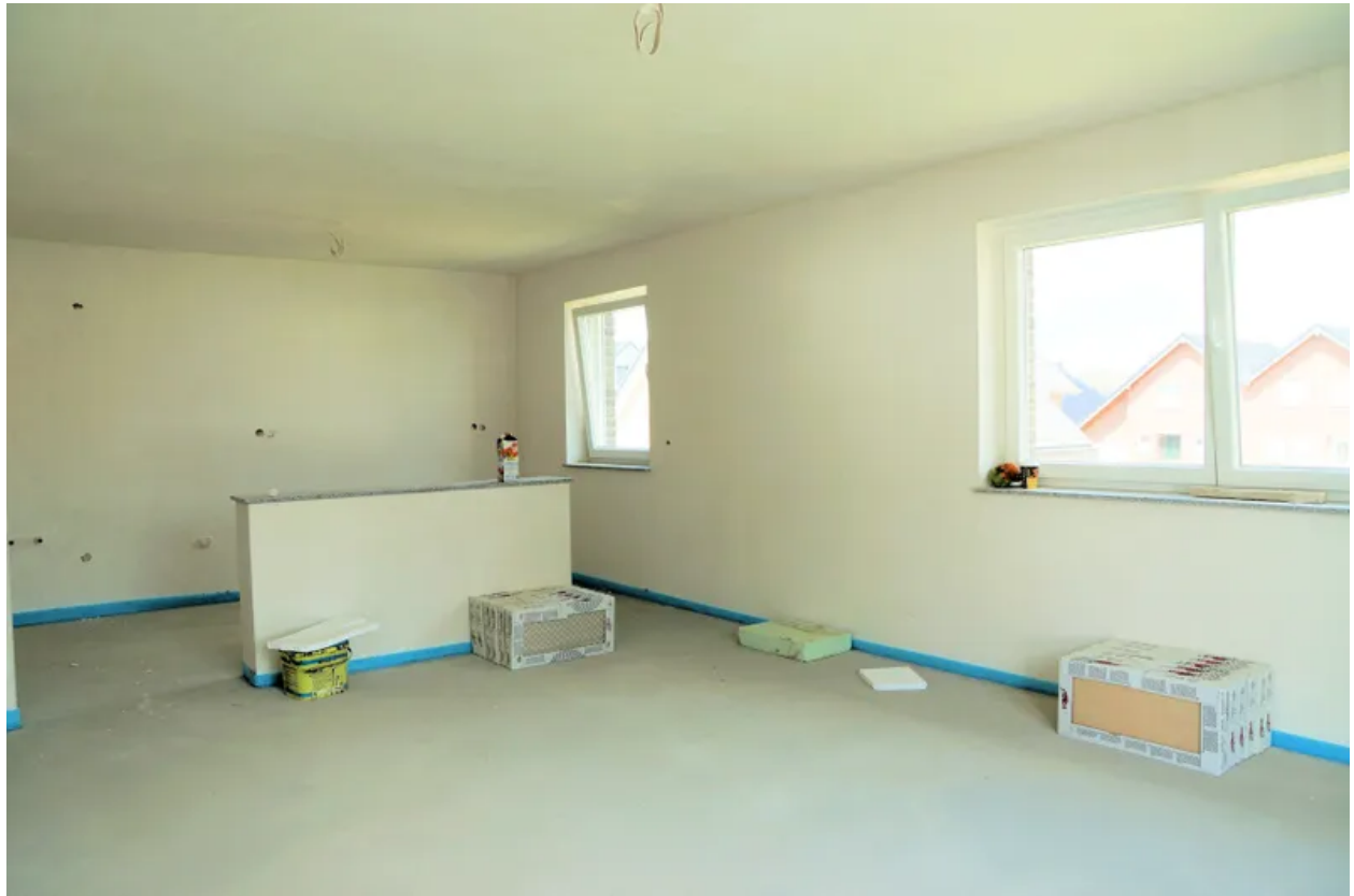
Küche und Wohnbereich
