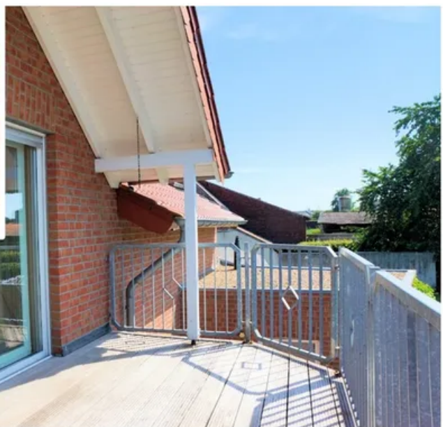
Balkon und Ausblick Haus 2
