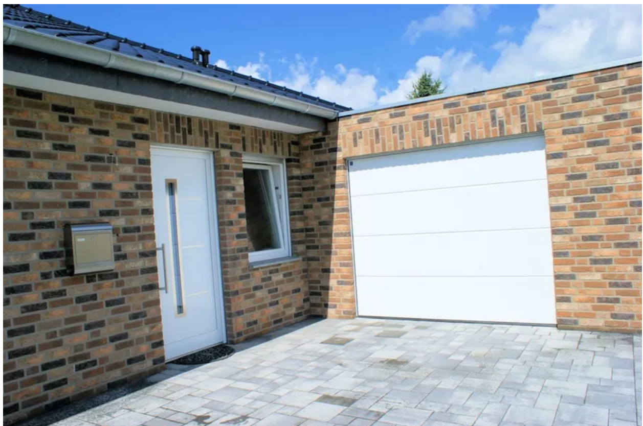
Eingang und Garage
