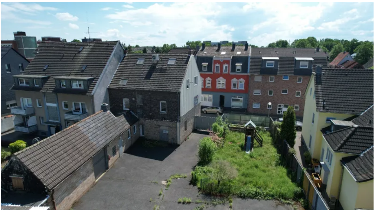
Noch steht der Altbau
