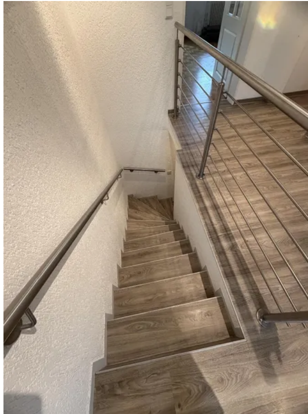
Treppe zum Kellergeschoss
