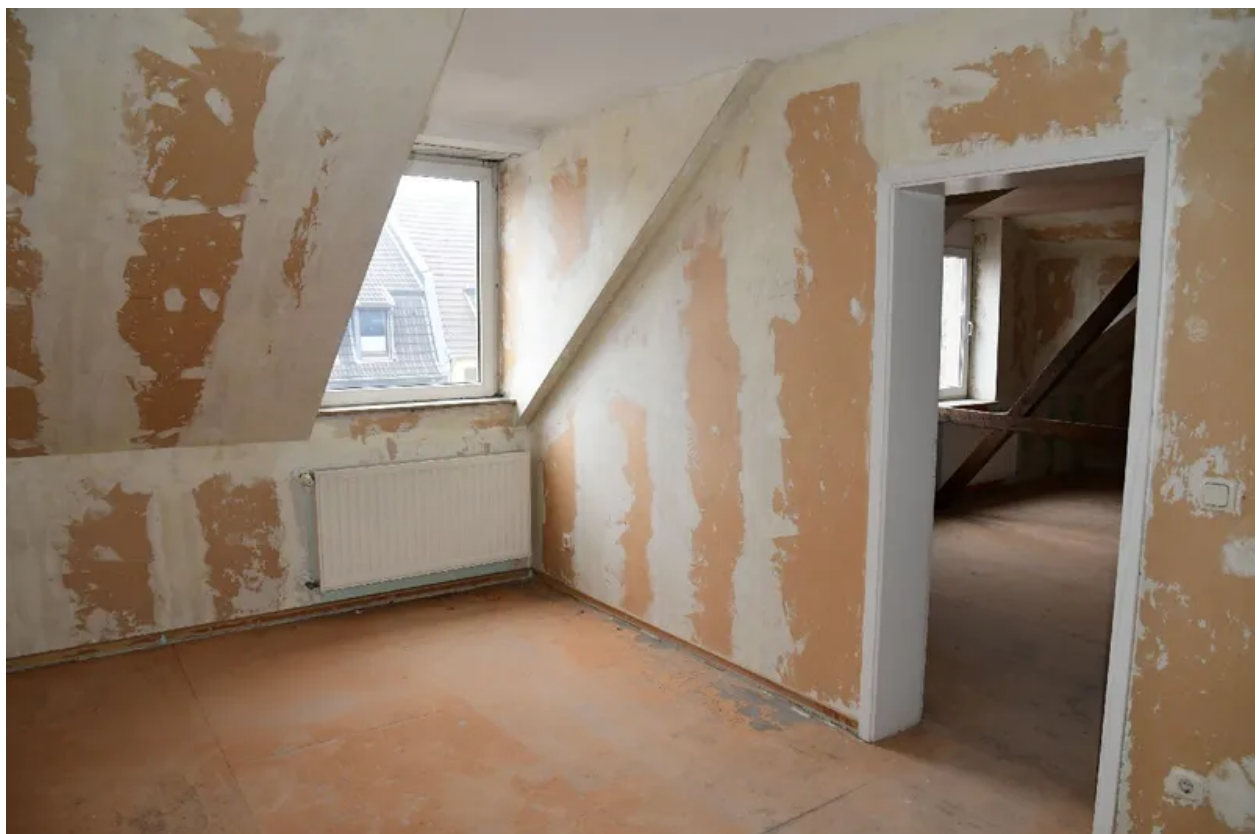
Raum 2 im 3. Obergeschoss
