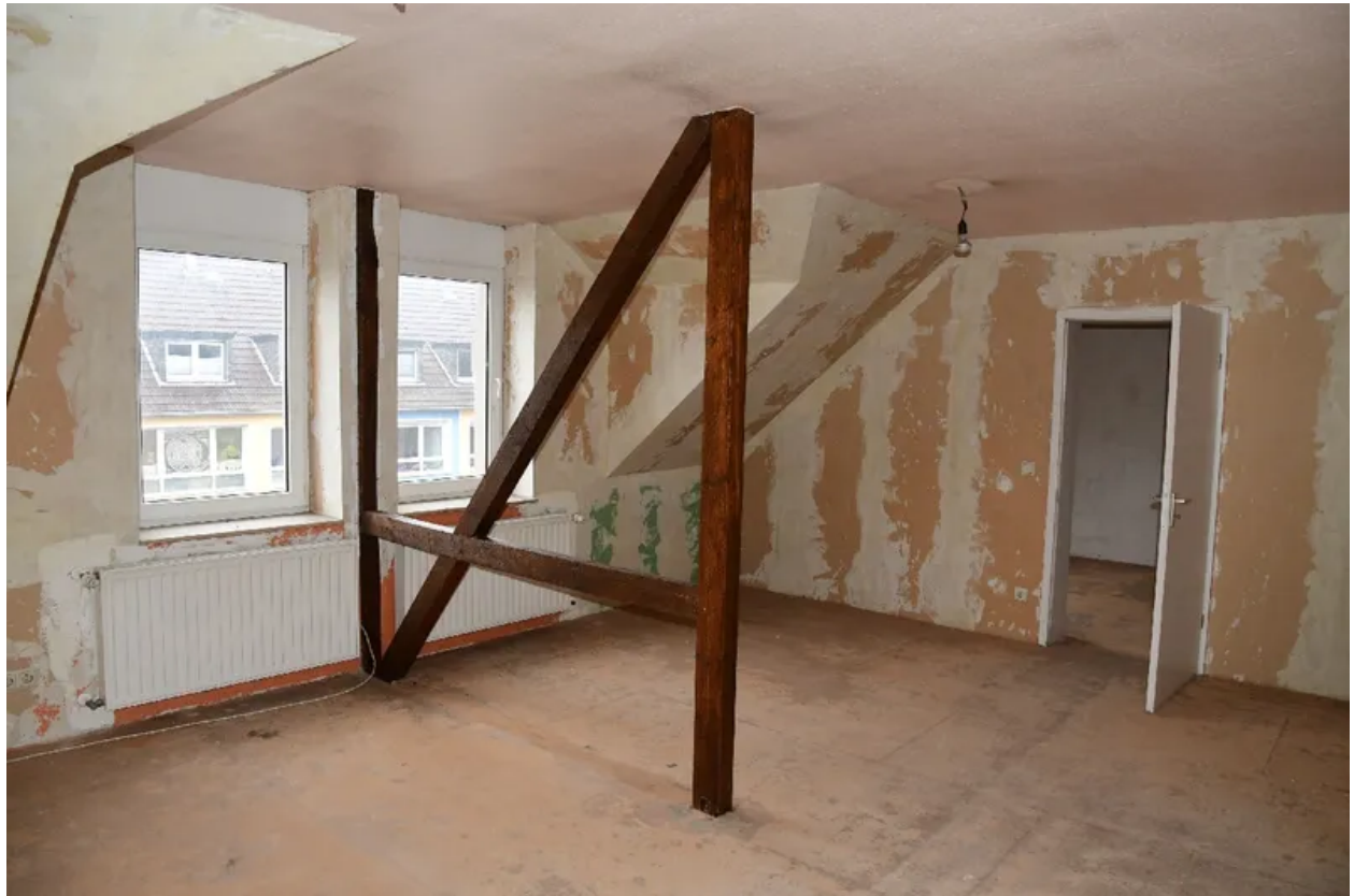
Raum 1 im 3. Obergeschoss
