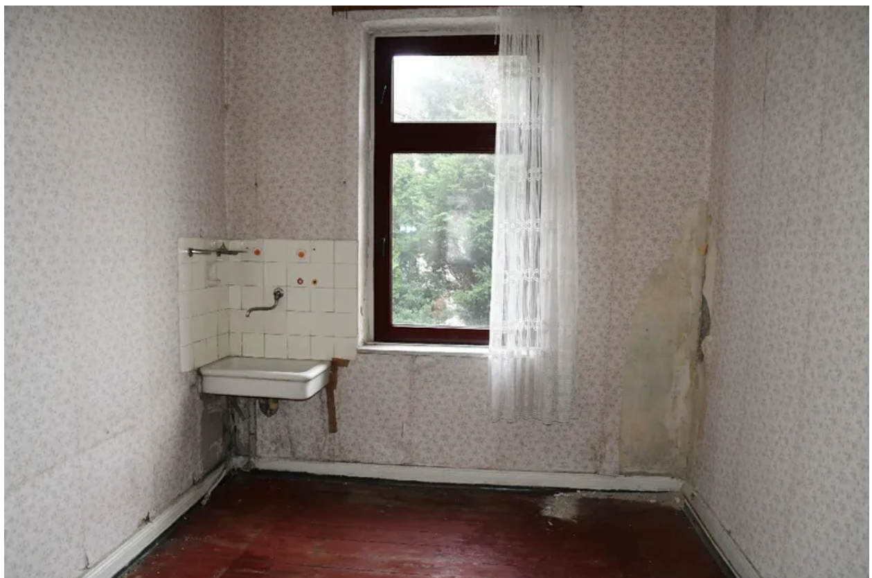
Raum 4 im 1. Obergeschoss
