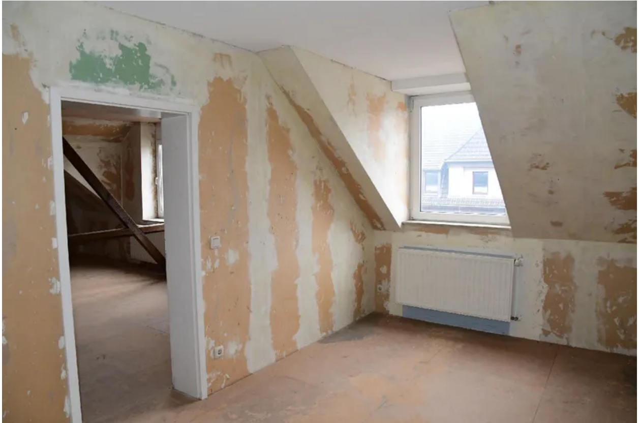
Raum 3 im 3. Obergeschoss
