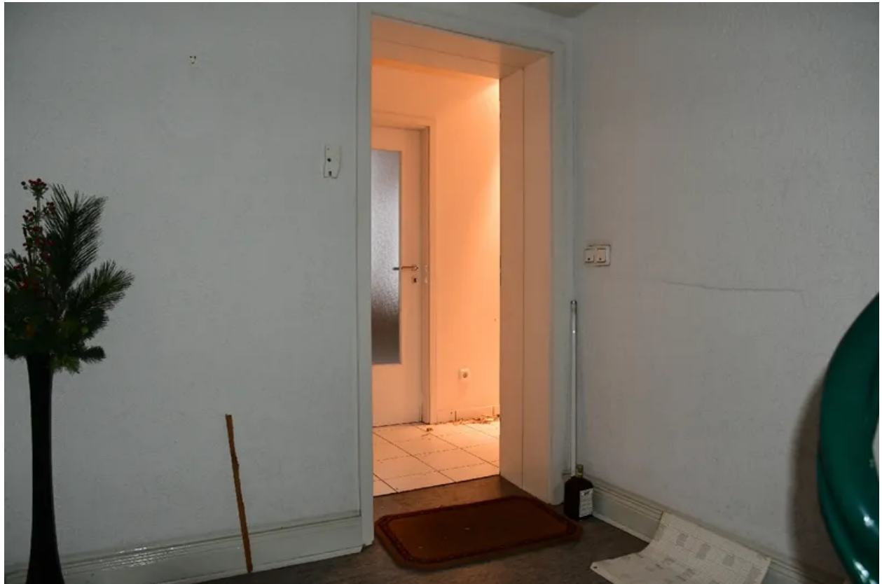
Eingang im 2. Obergeschoss
