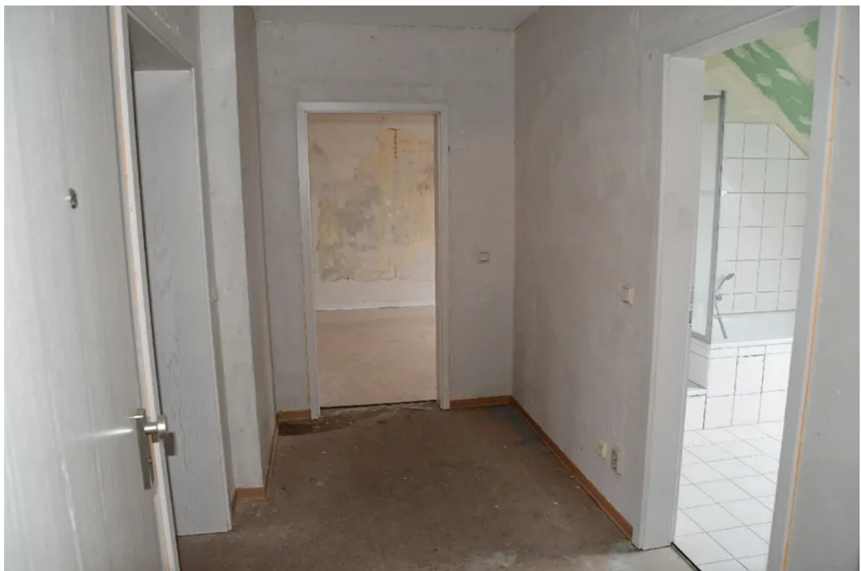
Eingang im 3. Obergeschoss
