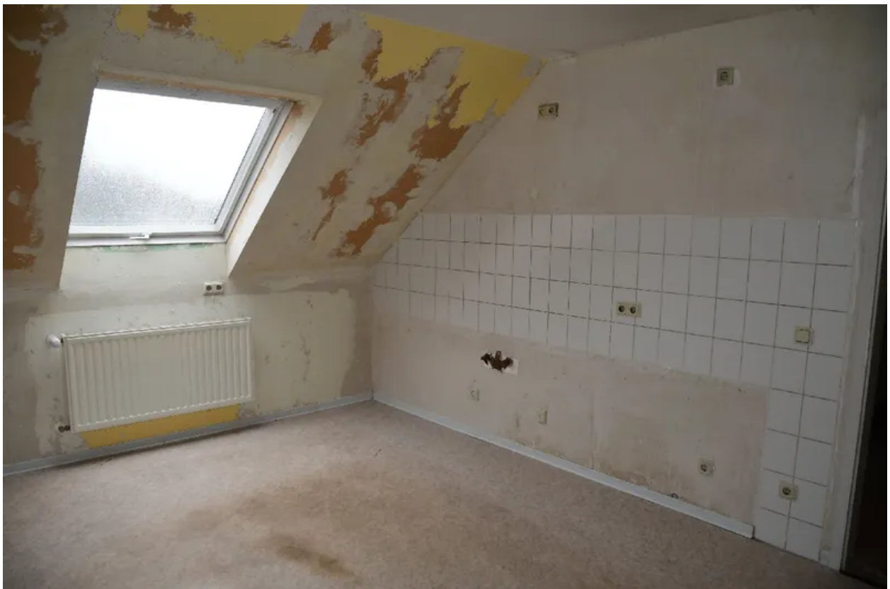
Küche im 3. Obergeschoss
