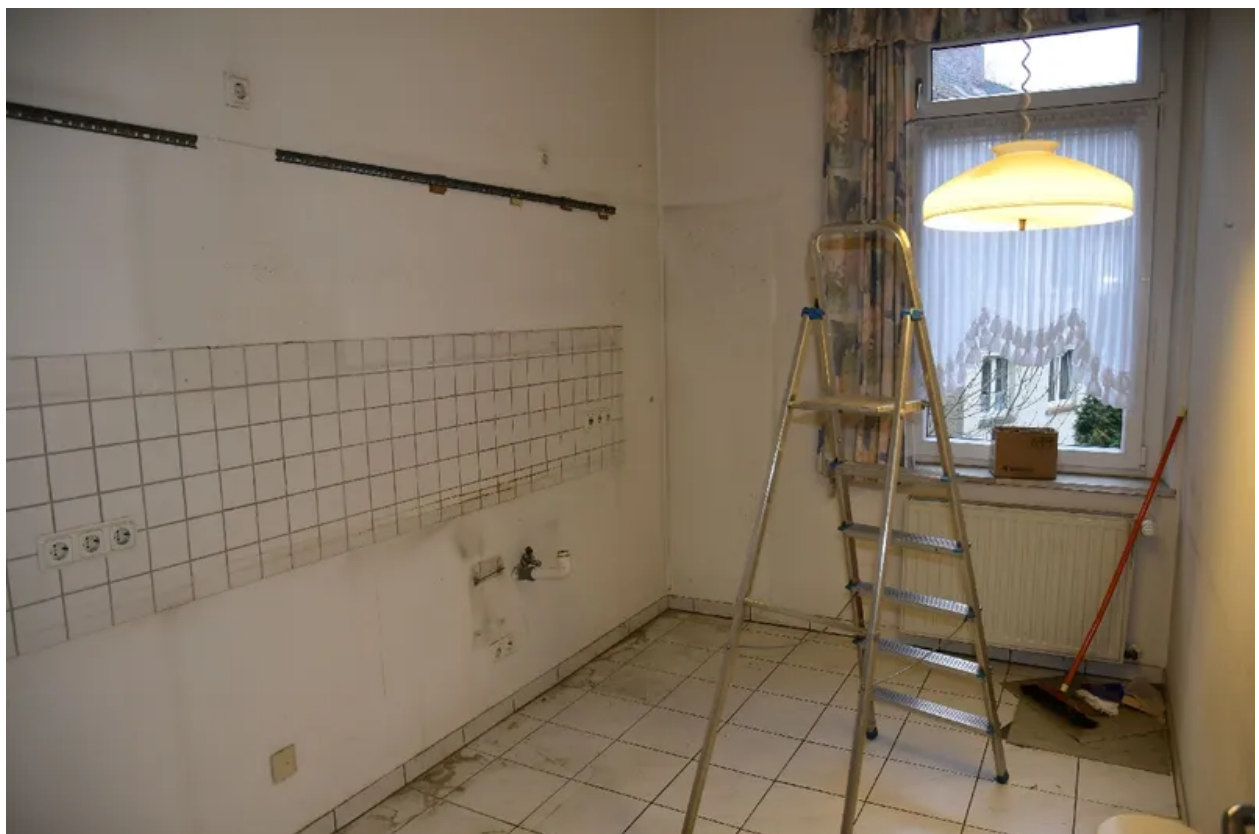
Küche im 2. Obergeschoss
