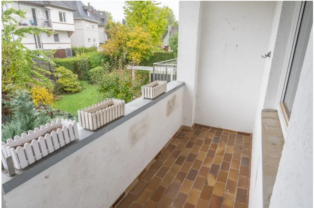
Die Loggia im OG
