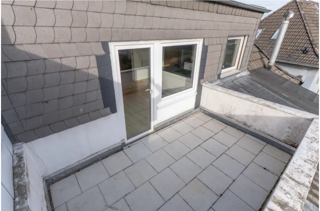
Großzügige Loggia im DG
