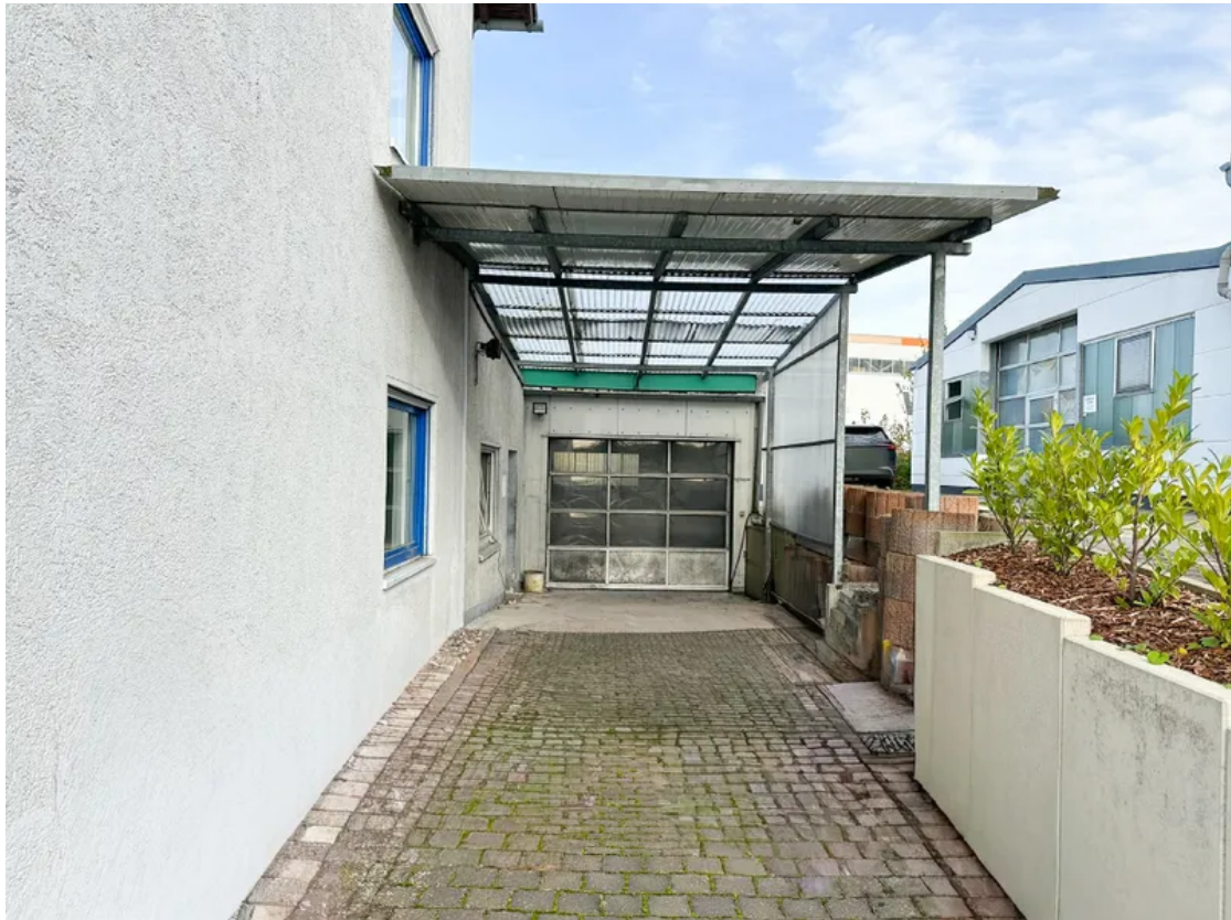
Halle (2) mit Zufahrt und Rolltor
