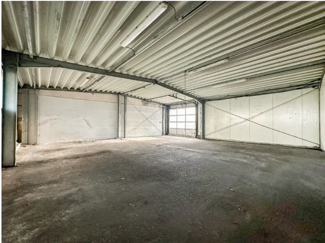
Halle (2) mit Zufahrt rechts am Büro
