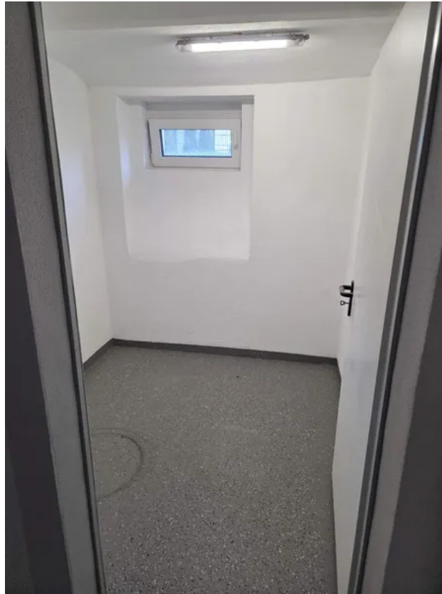
Keller im top Zustand!
