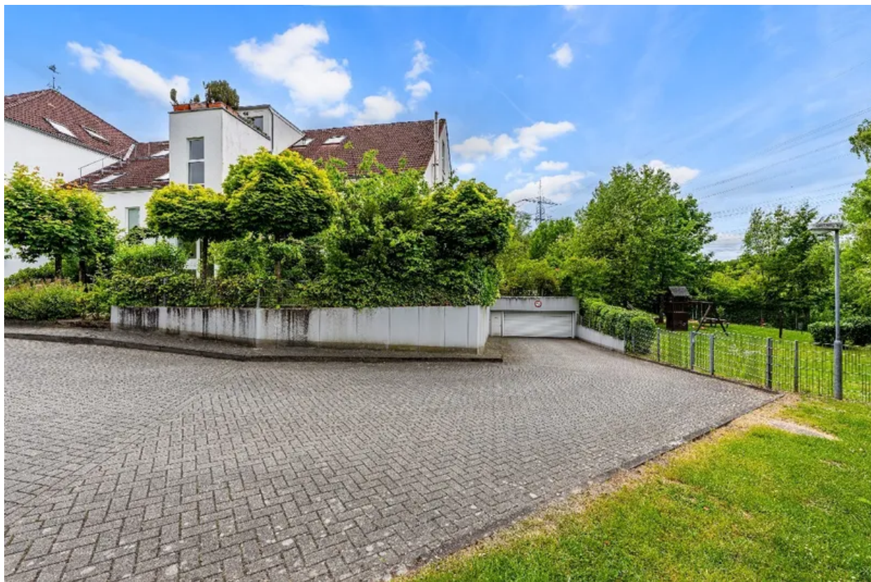
Einfahrt Tiefgarage und Spielplatz
