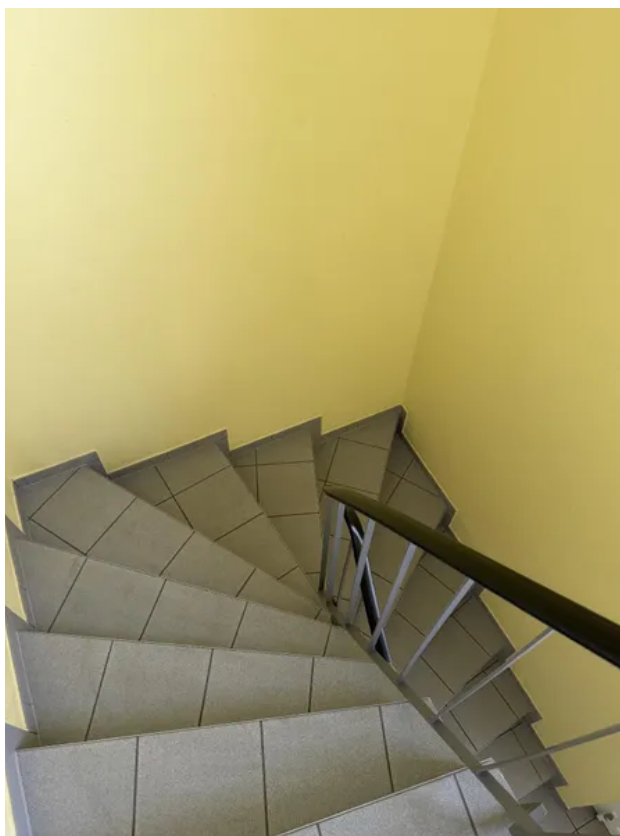
Treppe zum Erdgeschoss
