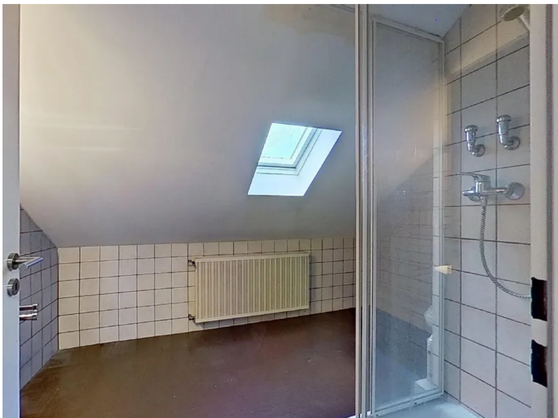
Duschbad im DG
