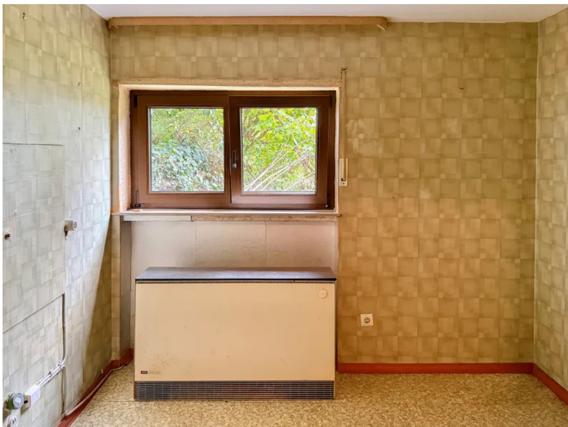
UG Zimmer (ehem. Waschküche)
