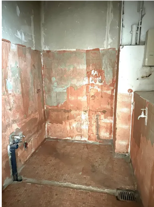
Küche vor der Renovierung
