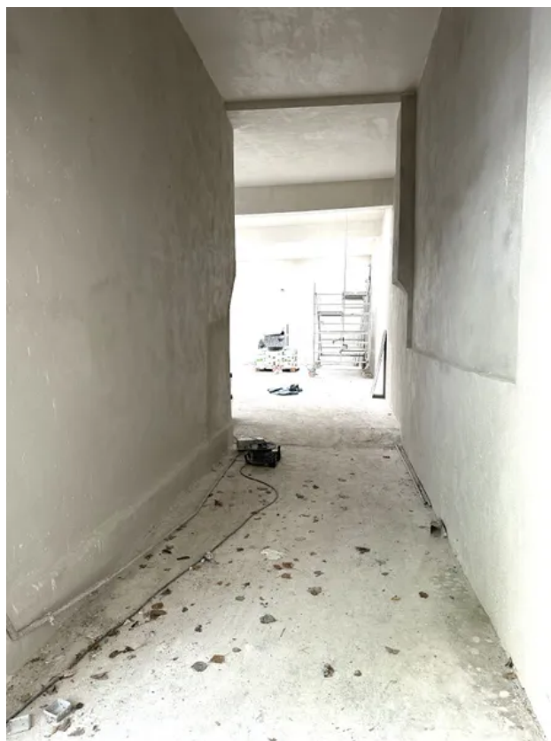
Einfahrt in die Halle
