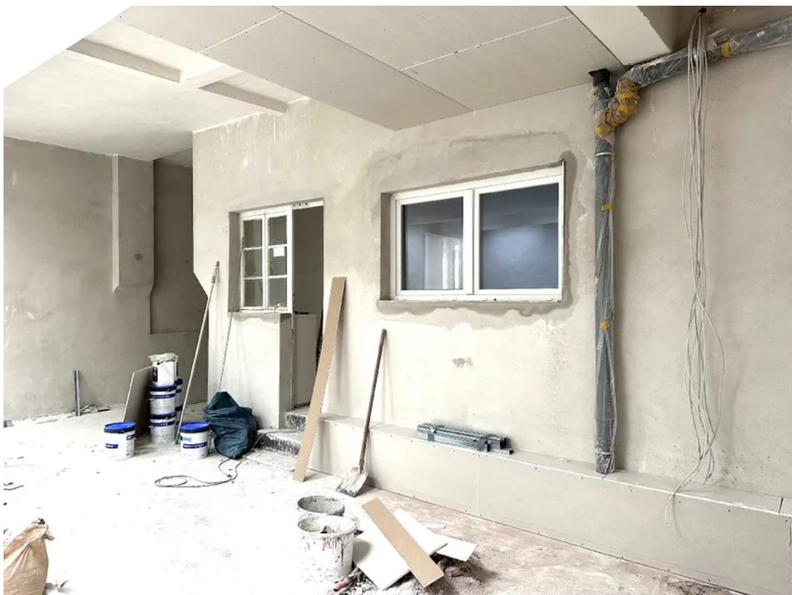
Blick Halle zum Büro + Sozialraum
