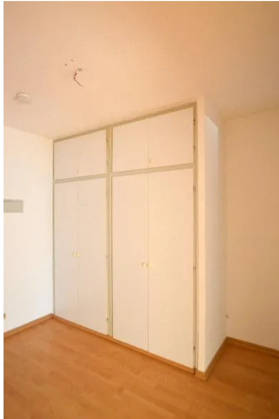
Einbauschränke in Diele
