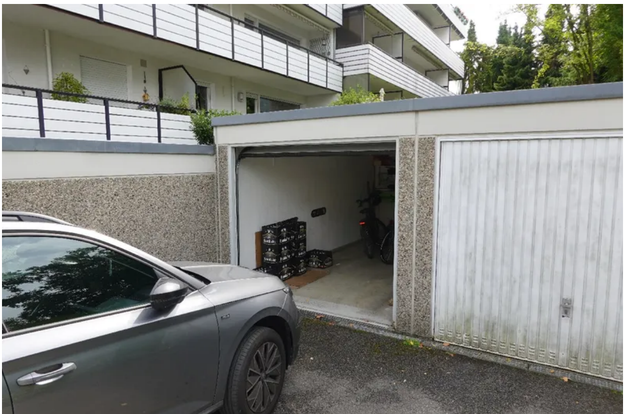
Garage direkt hinter dem Haus
