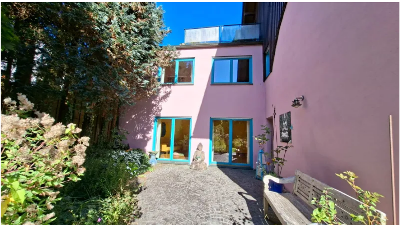
Rückansicht / Eingang Einliegerwohnung
