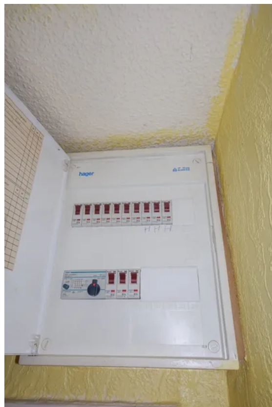
Modernisierte Unterverteilung
