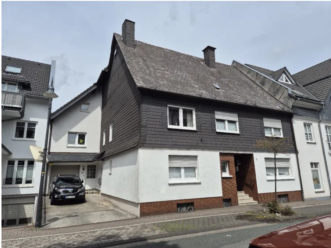
Ansicht mit Garage
