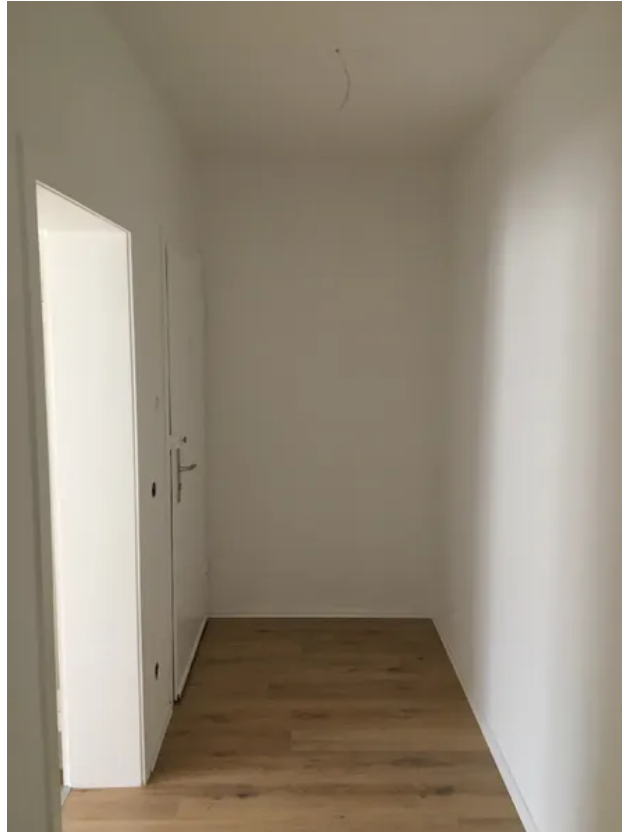
DG rechts - Flur
