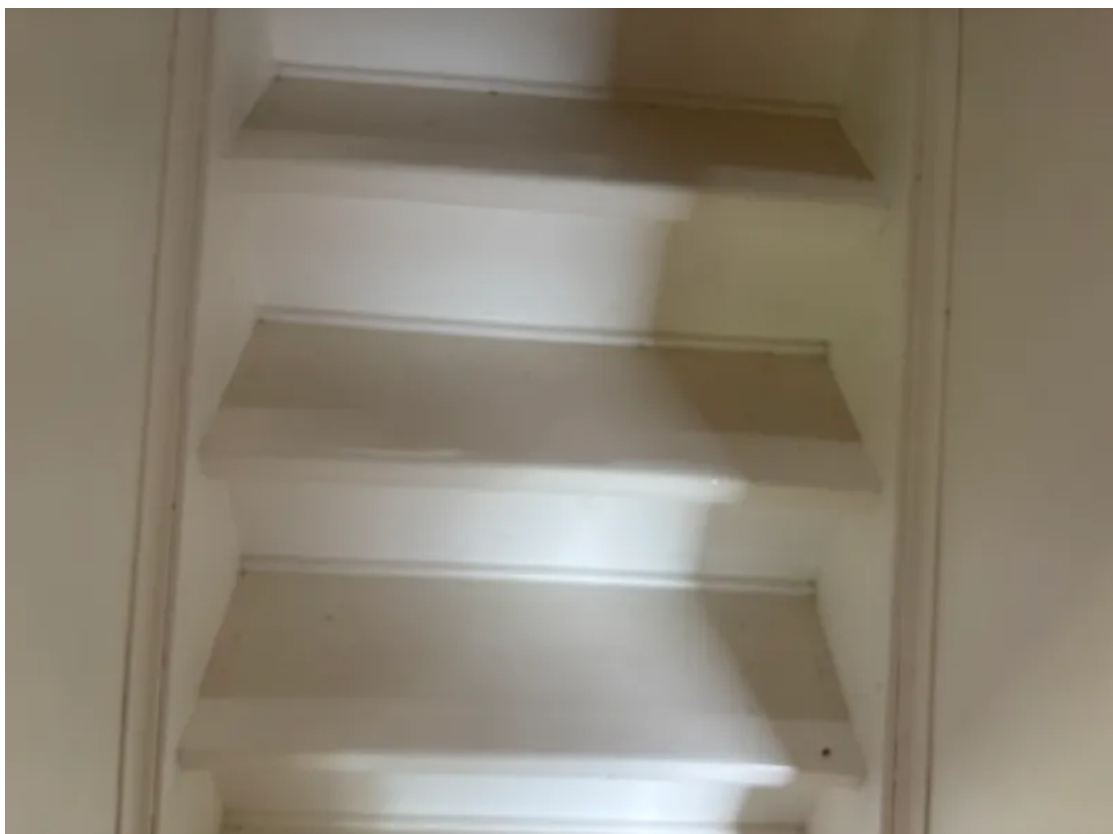
Treppe ins Dachgeschoss
