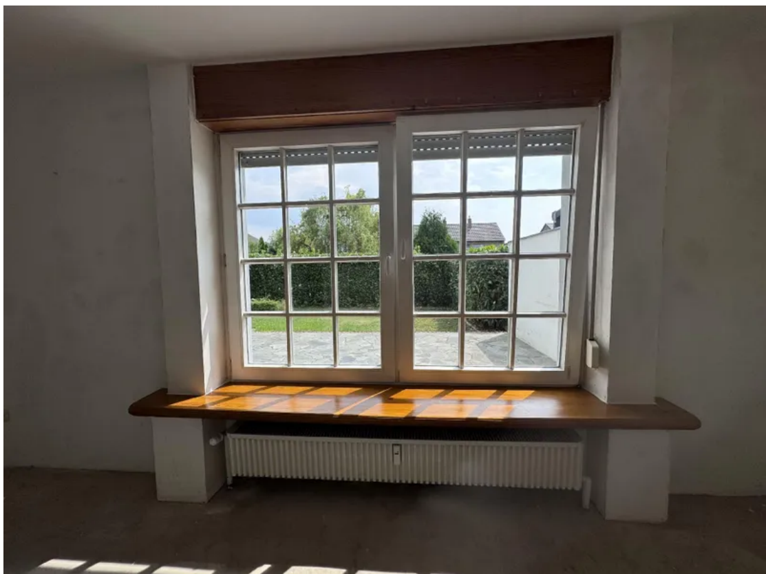
Fenster zum Garten Erdgeschoss
