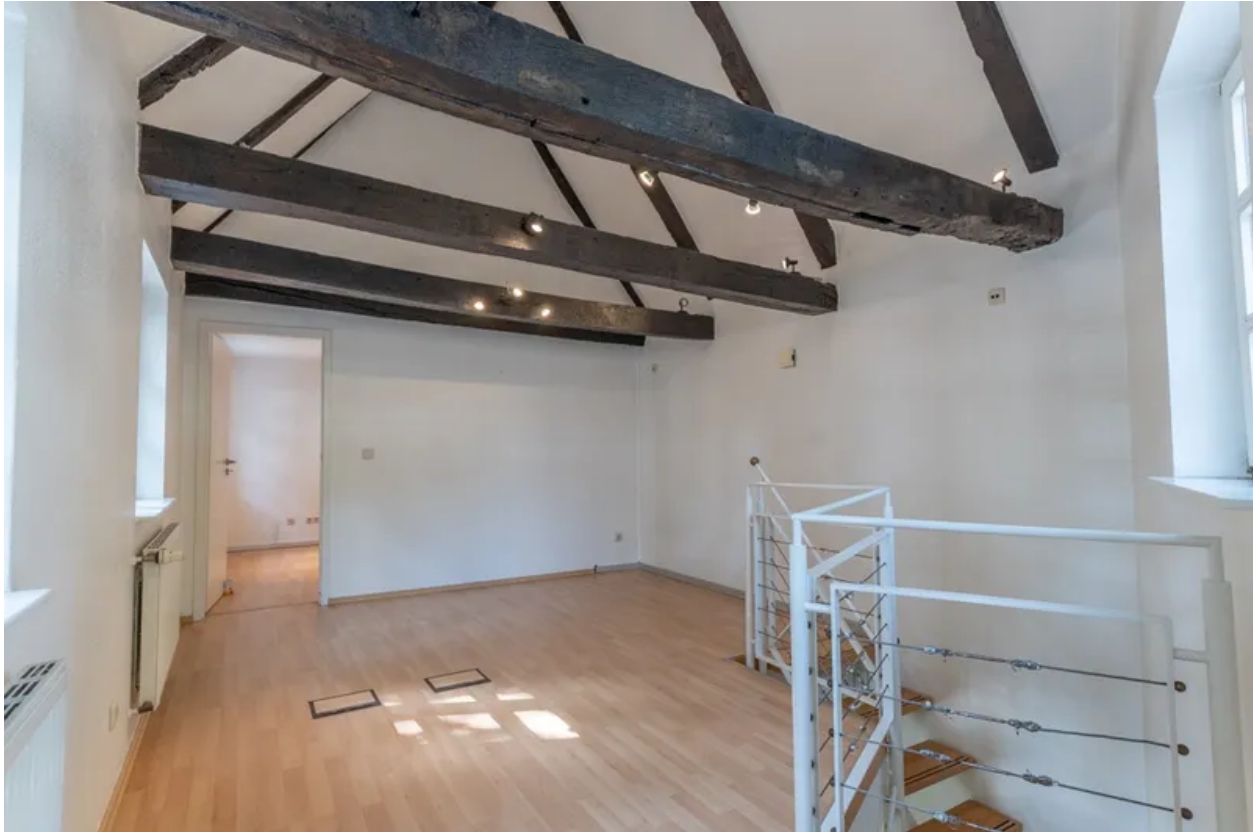
Büro/ Besprechungsraum im OG
