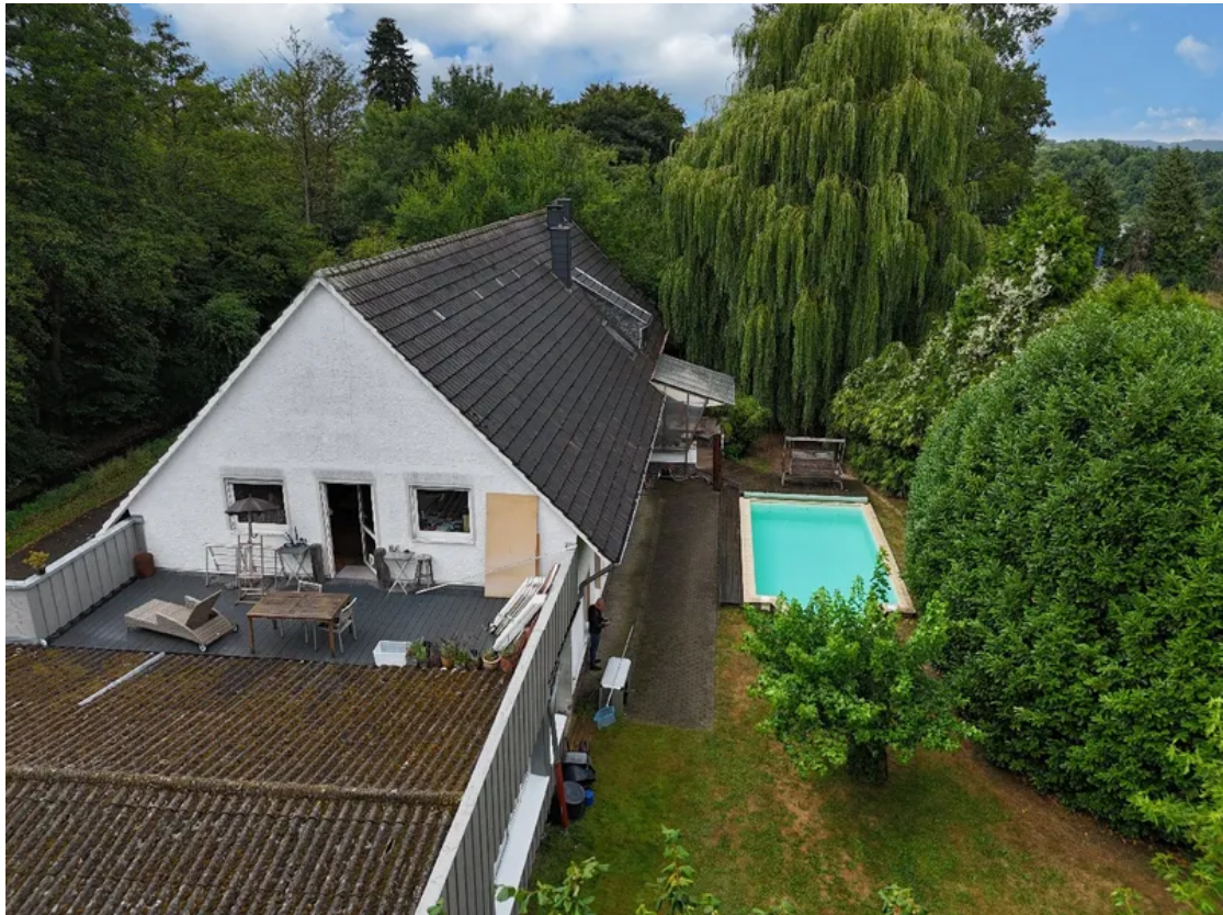
Terrasse im OG
