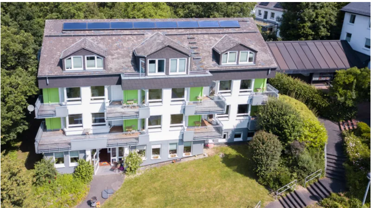
Luftaufnahme - rechter Gebäudeflügel
