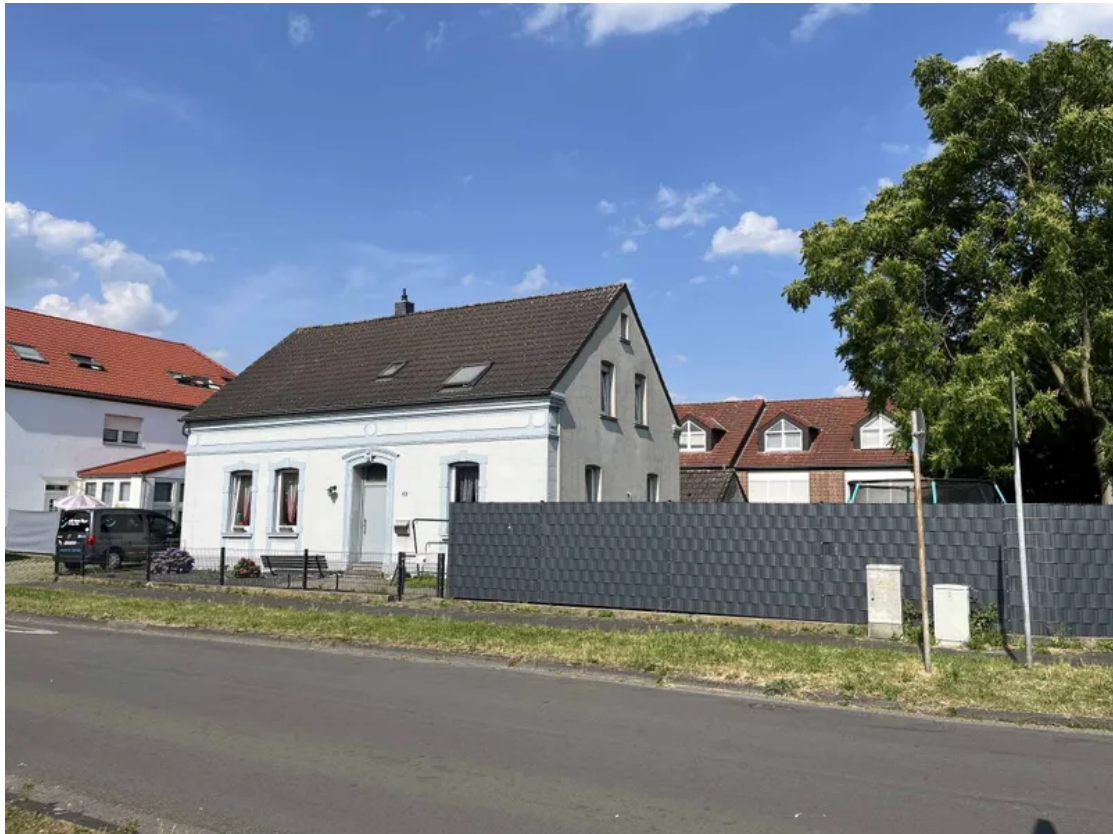
Charmantes Einfamilienhaus in Moers-Utfort
