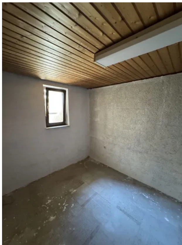
Kellerraum mit Fenster
