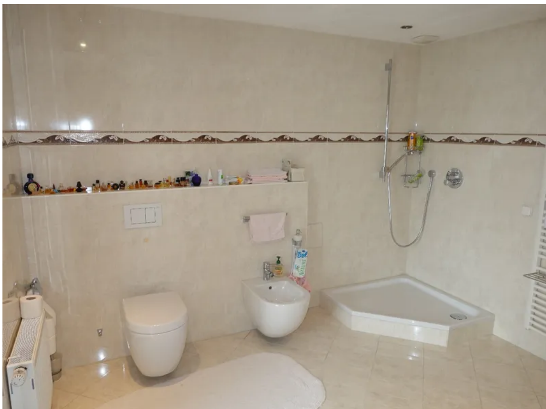
...Dusche, Bdet und WC
