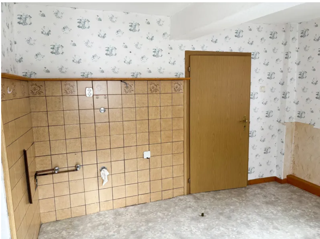
Alte Küche OG
