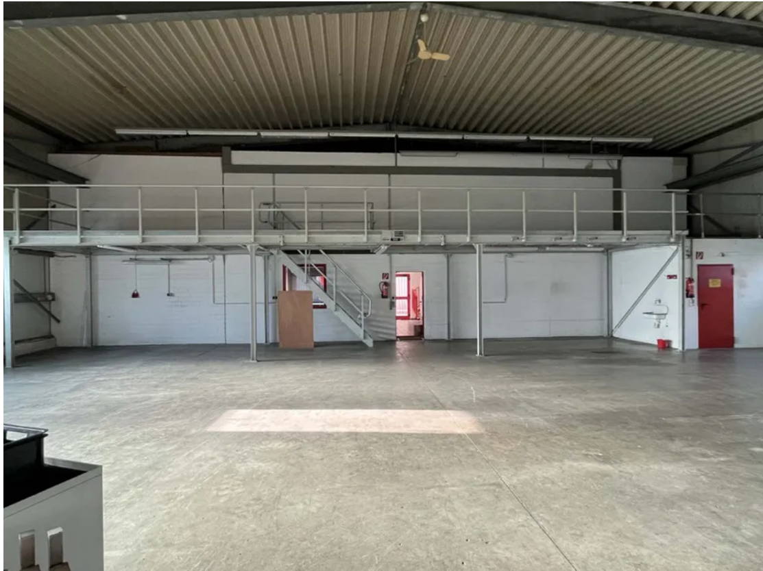
Halle mit Überbauung
