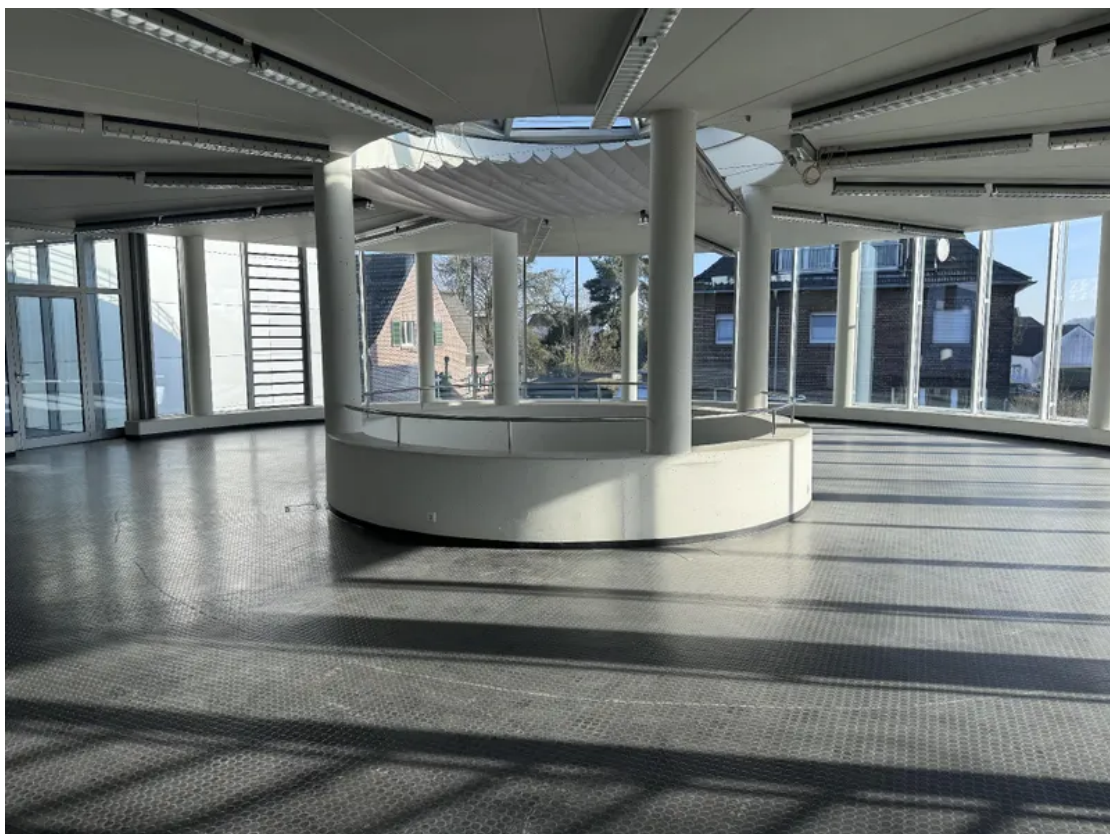
EDV Anschlüsse in den Böden
