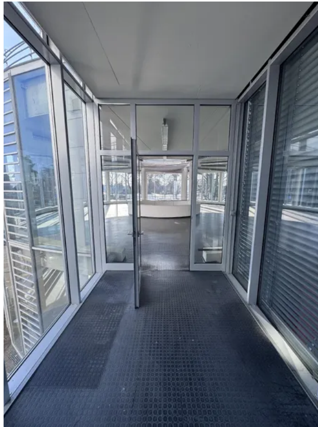
Durchgang zum Aufzug
