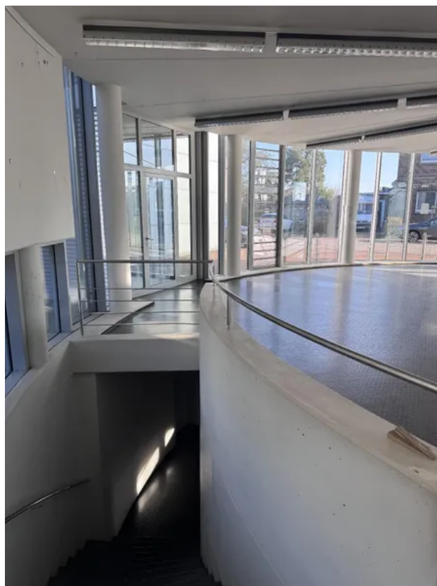
Abgang zum Lager/ Untergeschoss
