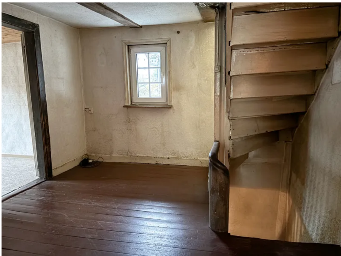
Flur OG Altbau
