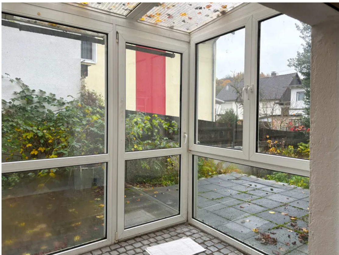
Wintergarten EG Anbau
