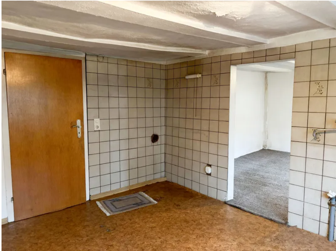
Küche EG Altbau
