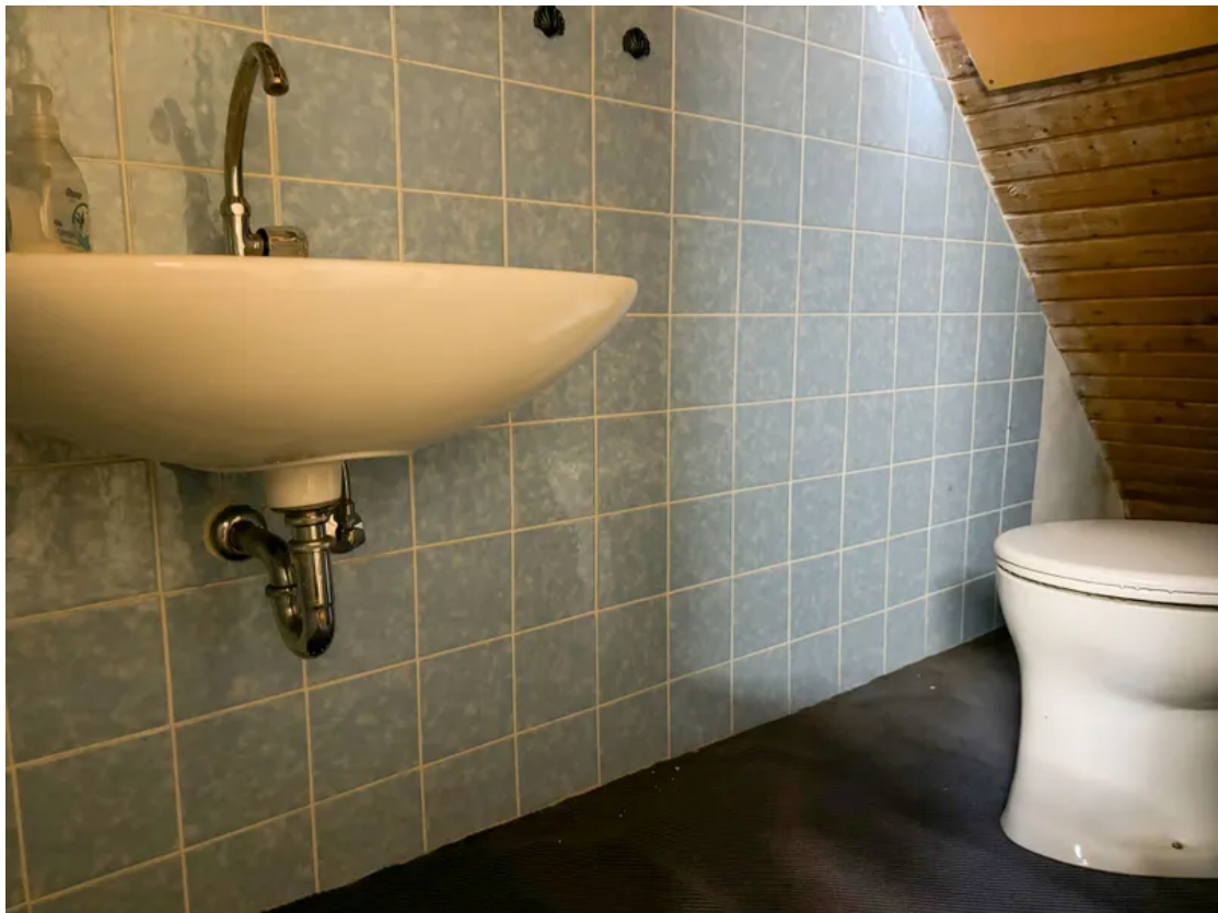
WC Dachboden Altbau
