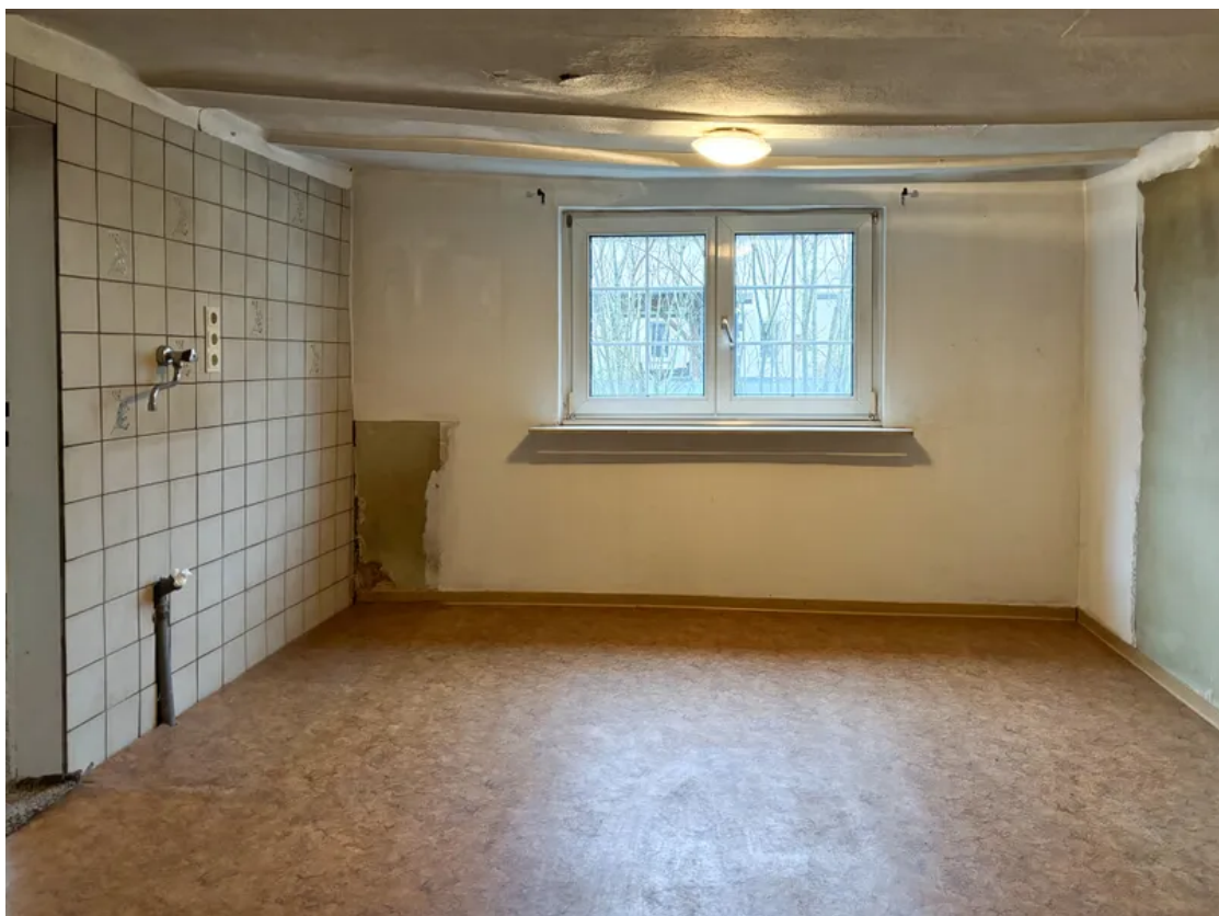
Küche EG Altbau
