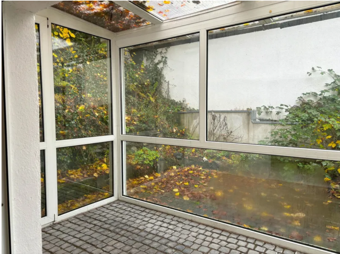
Wintergarten EG Anbau
