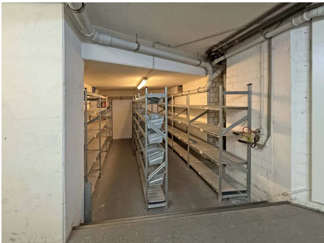
Lager im Keller
