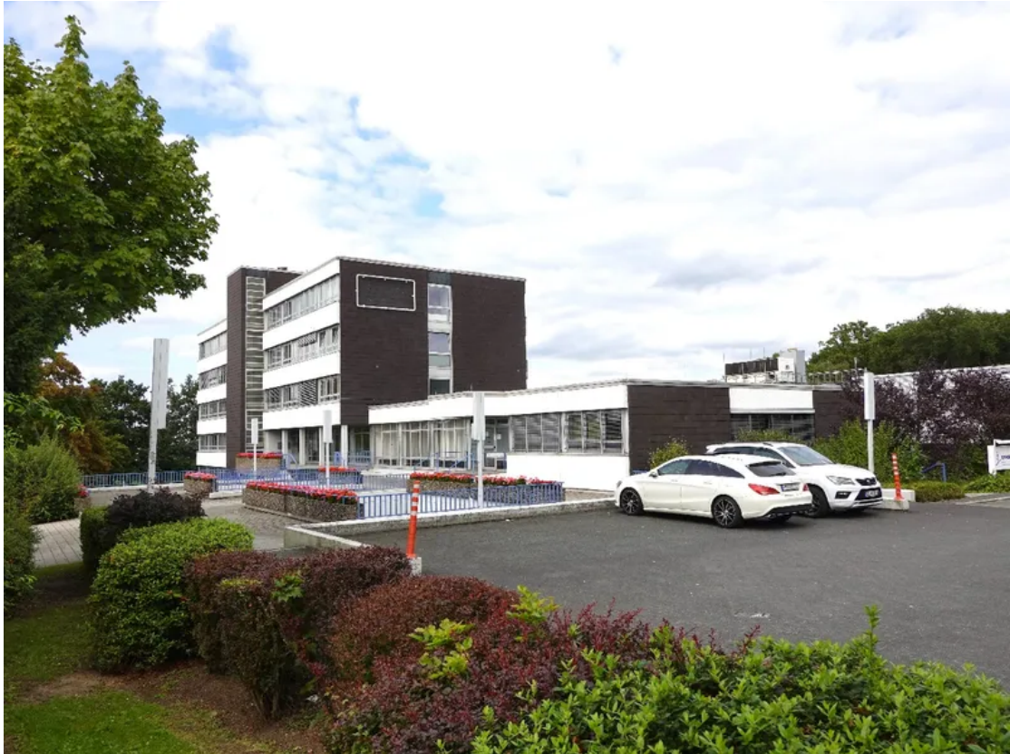
Frontansicht- Kundenparkplätze direkt vor dem Gebäude
