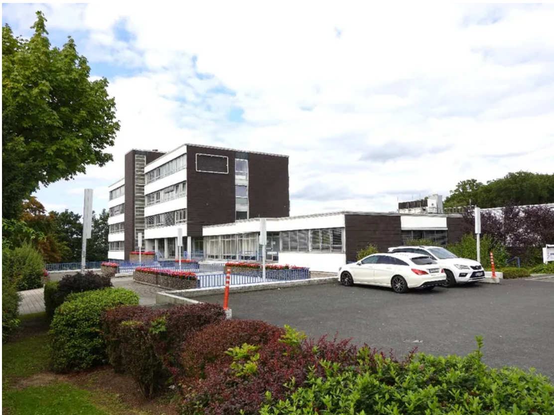
Frontansicht- Kundenparkplätze direkt vor dem Gebäude
