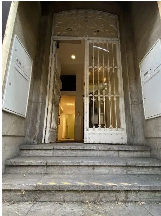
Eingang mit Automatiktür
