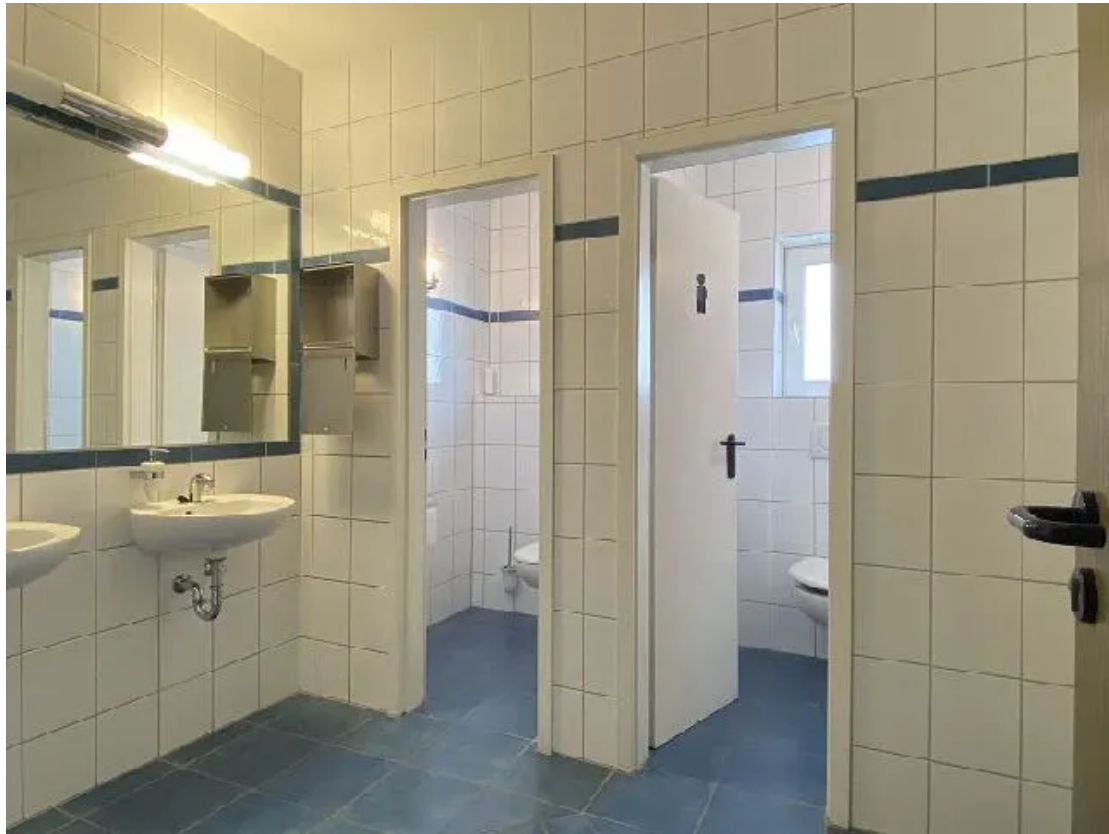
Sanitäreinrichtungen 1.OG Flügel
