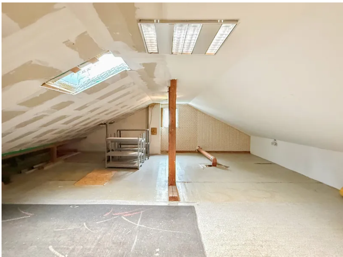
Ausbaubarer Raum DG
