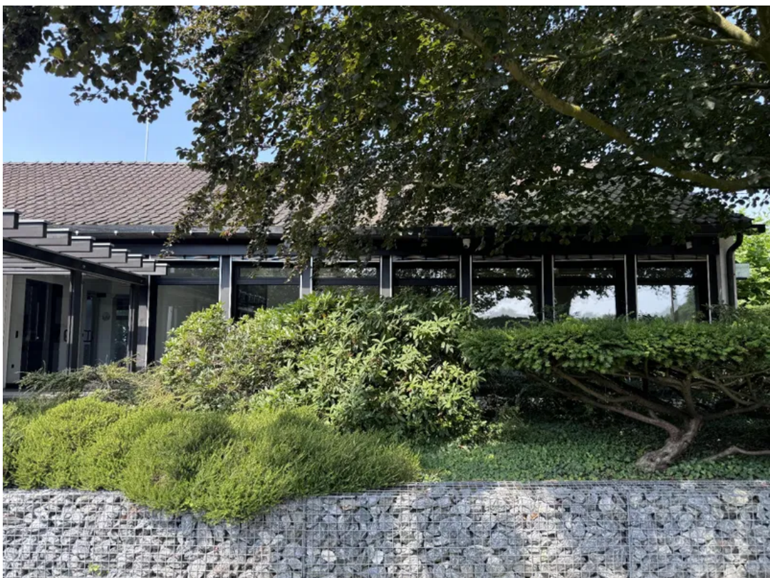
Büroräume mit Stellplätzen
