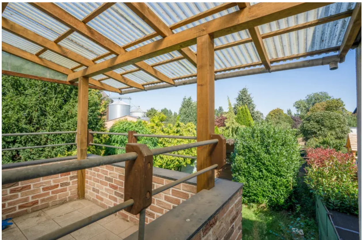
Überdachter Freisitz OG
