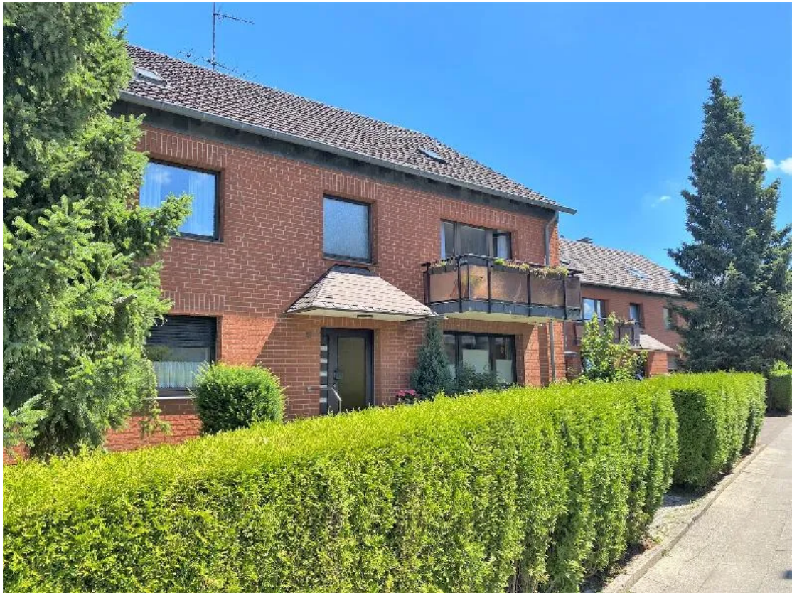
Ansicht Straßenseite Haus 2
