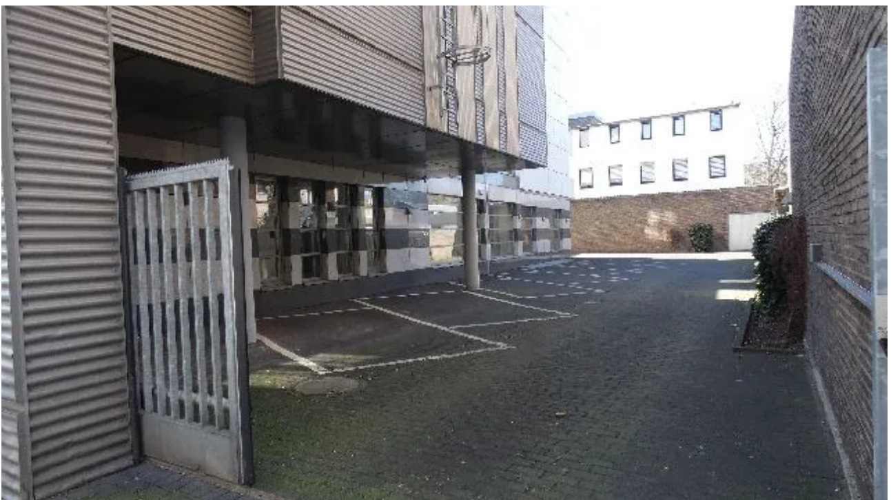
Innenhof mit PKW-Stellplätzen
